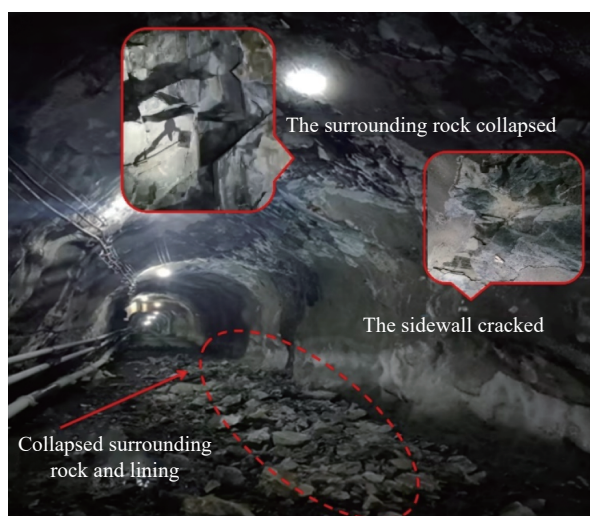
图 2 1880 m 分段巷道衬砌垮落
