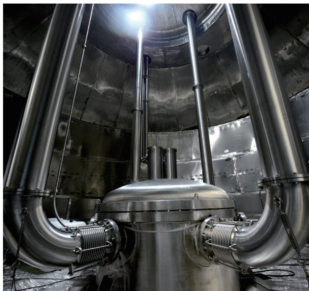
图1 900吨纯水罐中心 PandaX-4T 探测器
