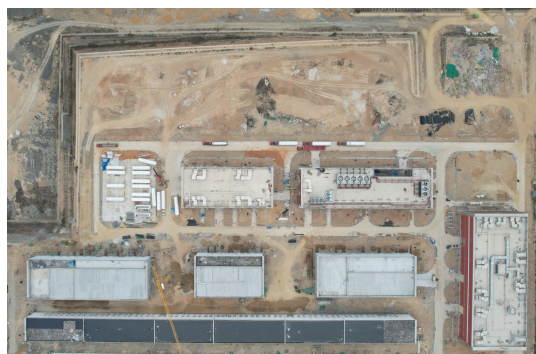
图 8 CiADS 现场航拍(2024 年 2 月 27 日)
